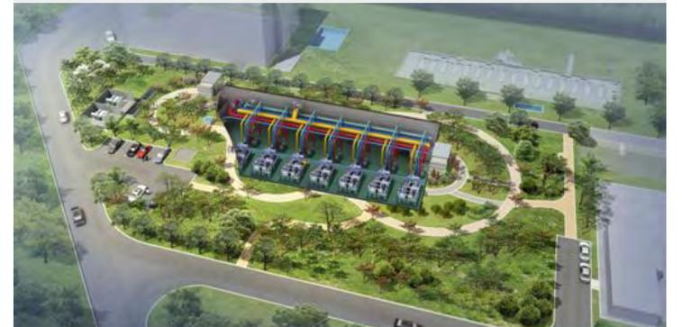
탄천 물재생센터 인근에서 한강으로 배출되는 생활 하수는 매일 110만 톤으로, 최종 방류 시 평균 12°C의 열을 가지고 있습니다. 포스코인터내셔널은 하수처리장에서 처리 후 버려지는 열에너지를 히트펌프로 회수해 인근 지역의 난방열로 공급하고 있습니다. 이는 민간 기업 최초이자 국내 최대 규모의 하수열 난방시설로, 연간 2만 가구가 사용할 가능한 난방용 에너지(연간 20만 Gcal)를 생산합니다. 이는 연간 2만 톤의 석유를 대체하는 효과이자, 약 3만 4,000톤의 이산화탄소를 감축하는 효과를 창출하고 있습니다.
