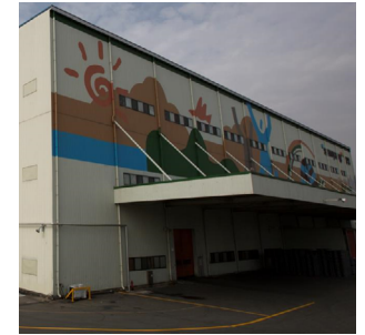
대전2공장 (PET병, PET프리폼) 대전광역시 대덕구 신일서로17번길 93
