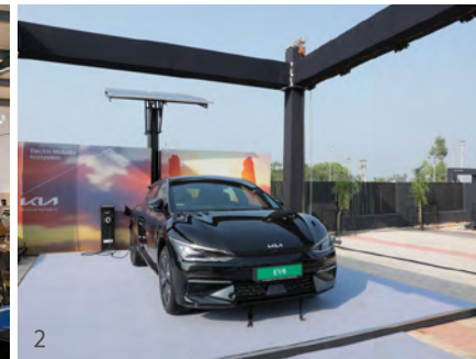
1. 기아 스토어 지속가능성 가이드라인 적용 거점 2. 태양광 EV 충전기
