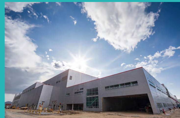
2023년 10월 준공된 SK넥실리스 말레이시아 1공장의 전경
