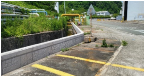
범람 취약 지역 차수벽 설치
