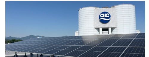
연구소 태양광 발전시설
