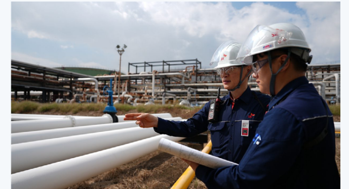
SK이노베이션 울산Complex 외항부두 관리감독
