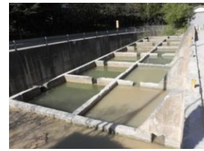
다단계 침사지 준설
