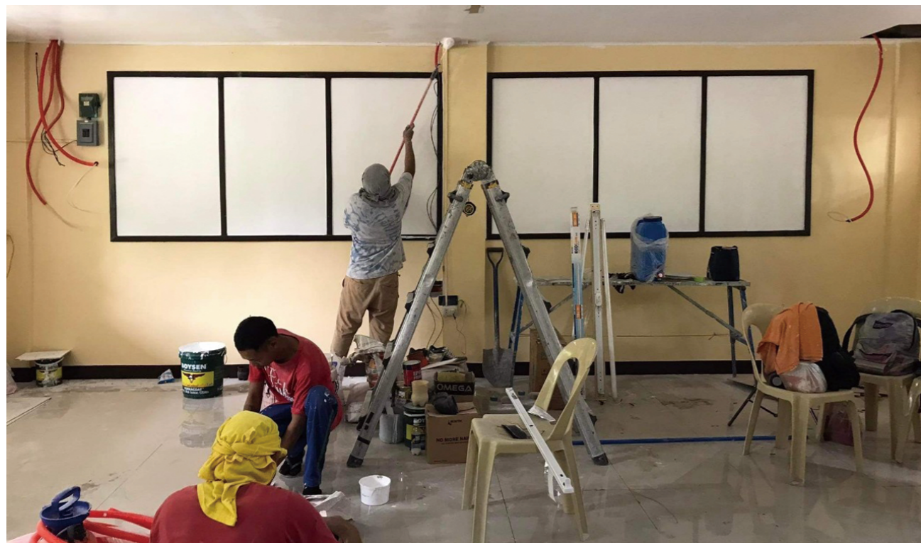
필리핀 도서관 개보수 공사
