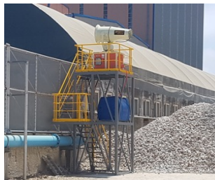
광대역 살수 설비 설치
