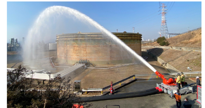
SK이노베이션 울산Complex 원유저장지역 대형 탱크(Tank)의 화재를 조기 진압하기 위해 '대용량 방사포' 국내 최초로 도입
