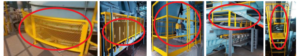
▲ 위험시설(사일로, 컨베이어) 인근 컨테이너 방호울 설치
