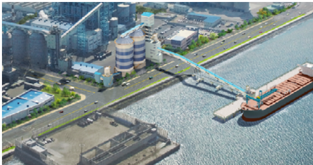
▲ 유연탄 이송 부두 시설 전경
