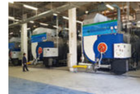
초저녹스 보일러 설치
