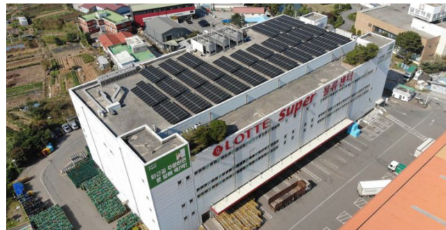
롯데슈퍼 태양광 설비
