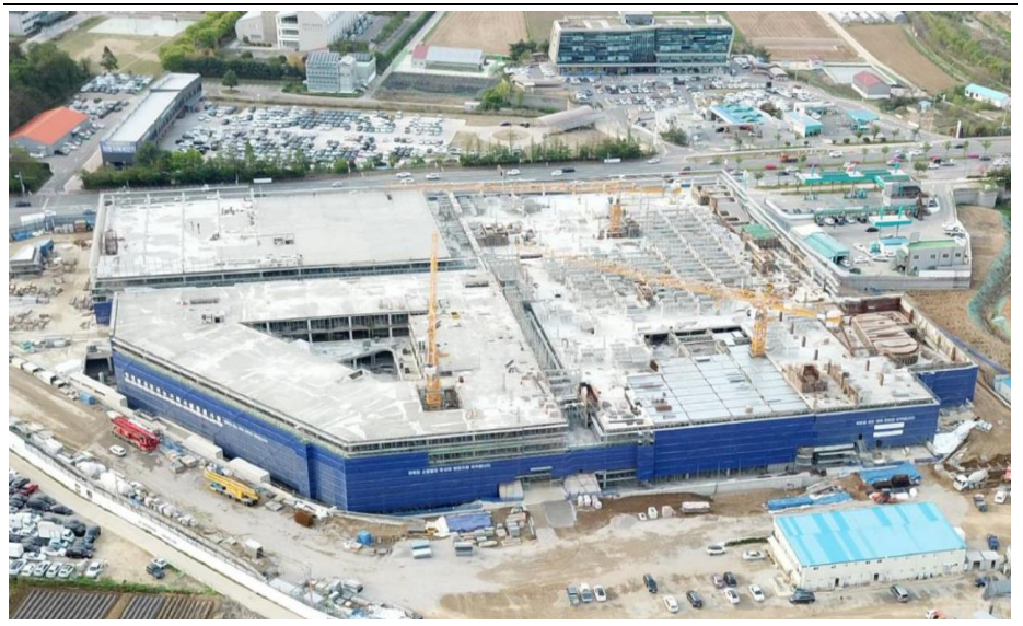
[그림 2] 도이치오토월드 공사 현장
