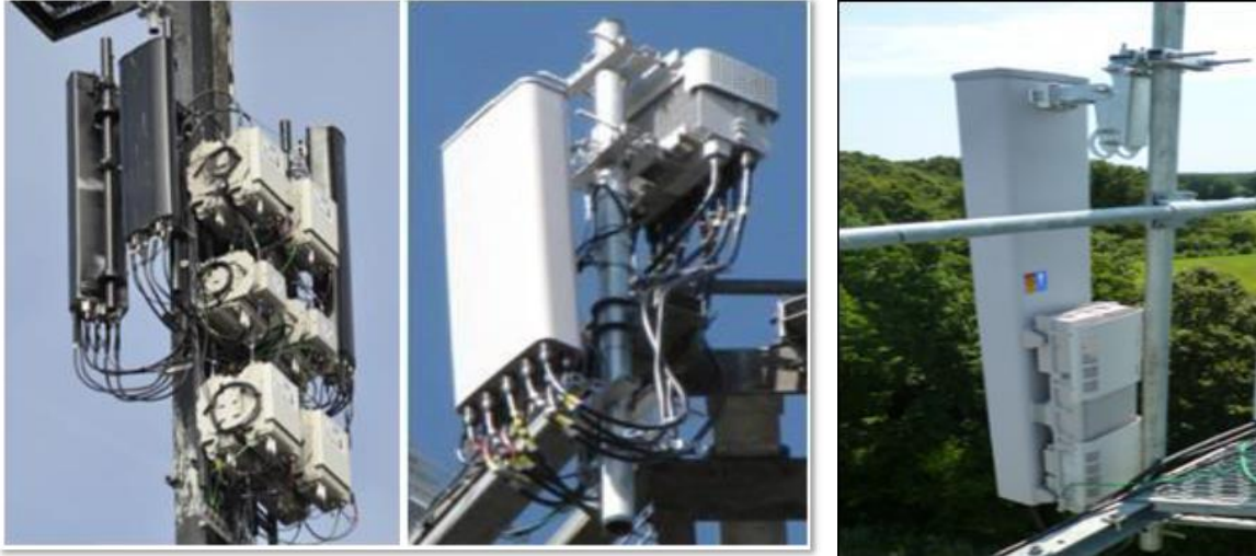
도표 16 사업 영역: RRH, Antenna, RRA(RRH + Antenna)
