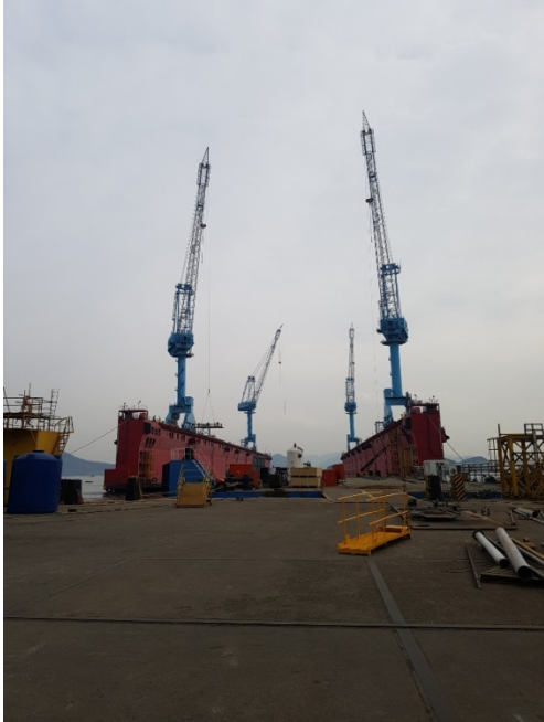
도표 3. FD(Floating Dock)를 안벽과 연결하여 작업 중
